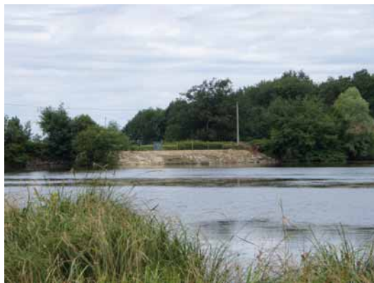
Site de pont de Cistude d'Europe, sur une digue d'étang, en partie détruit suite à un apport de remblai. Étang du Petit Baronnet, Martigny-le-Comte, Saône-et-Loire, 6 juillet 2011.
