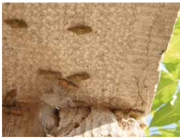
Amas de chrysalides sous un linteau (Haute-Saône, 2011).
