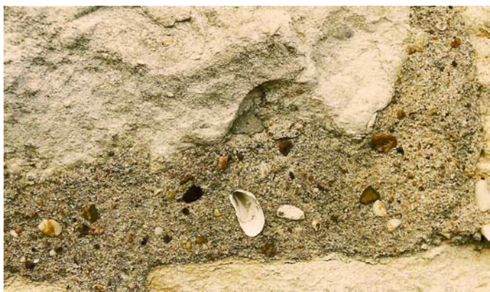
Photographie 1. Valve de Dreissène dans un mortier.
