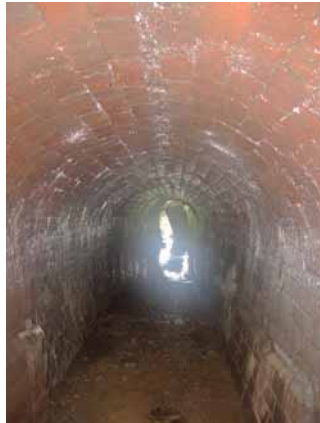
Tunnel avec au fond l'entrée habituellement obstruée par des tôles.
